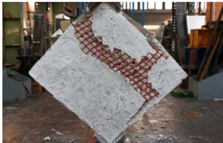
Prove di compressione diagonale
