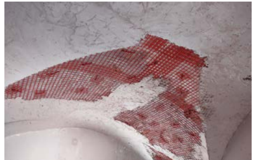
Volta in muratura intradosso
