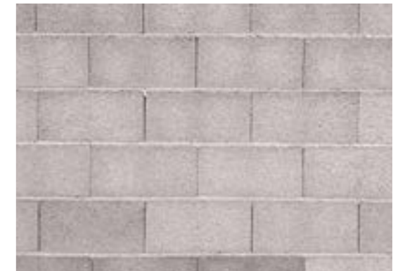
Preparazione del supporto
